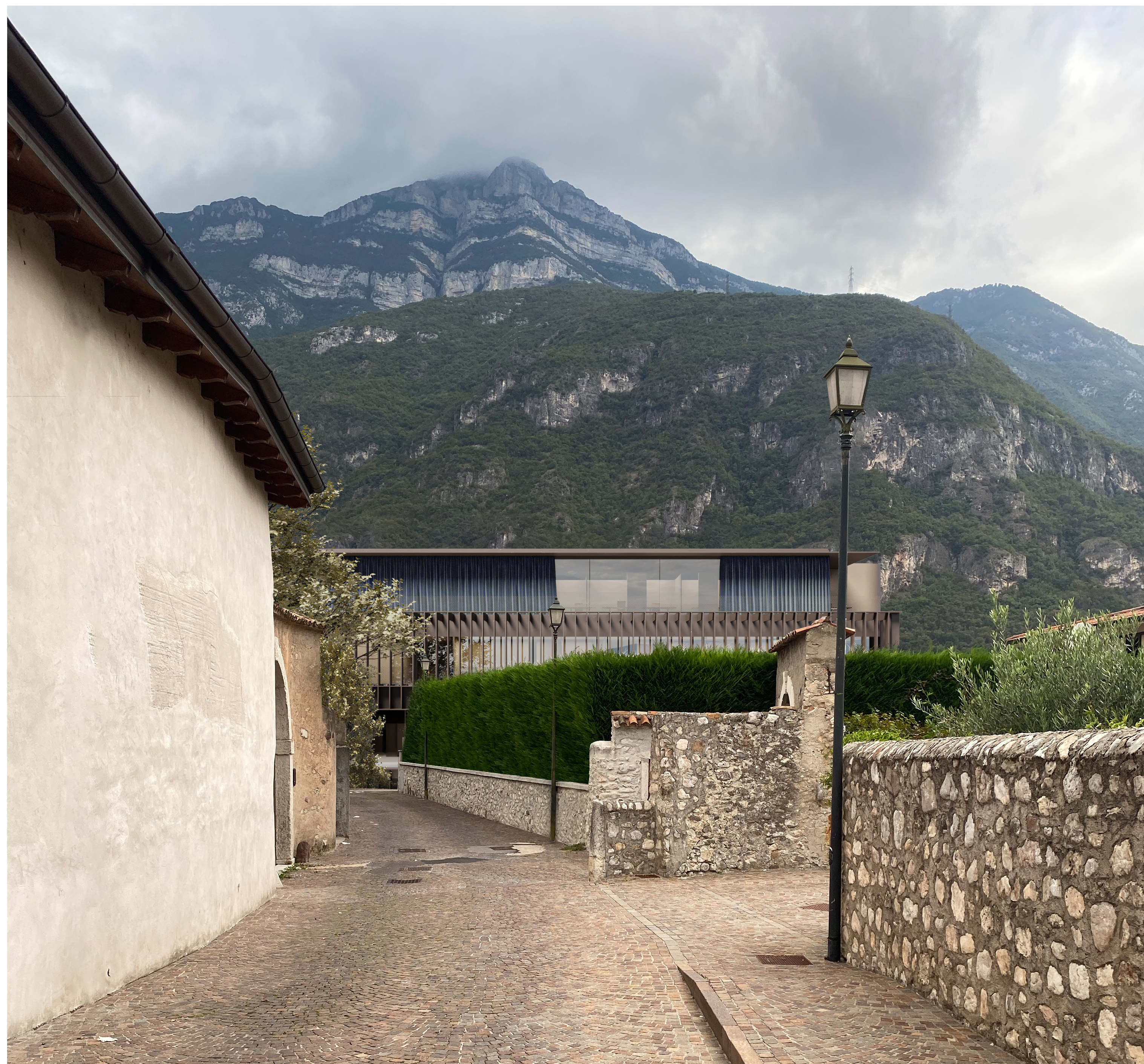
scorcio da via del Teatro | il dialogo con il tessuto esistente consiste in un rimando cromatico e nella compressione volumetrica dell'edificio che trasforma il piano di coronamento in una teca
